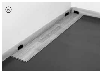
⑤ Lægningen startes i højre hjørne af rummet. Elementerne lægges med federsiden mod væggen og fikseres med afstandskiler (ekspansionsafstand til væg 10-15 mm).
